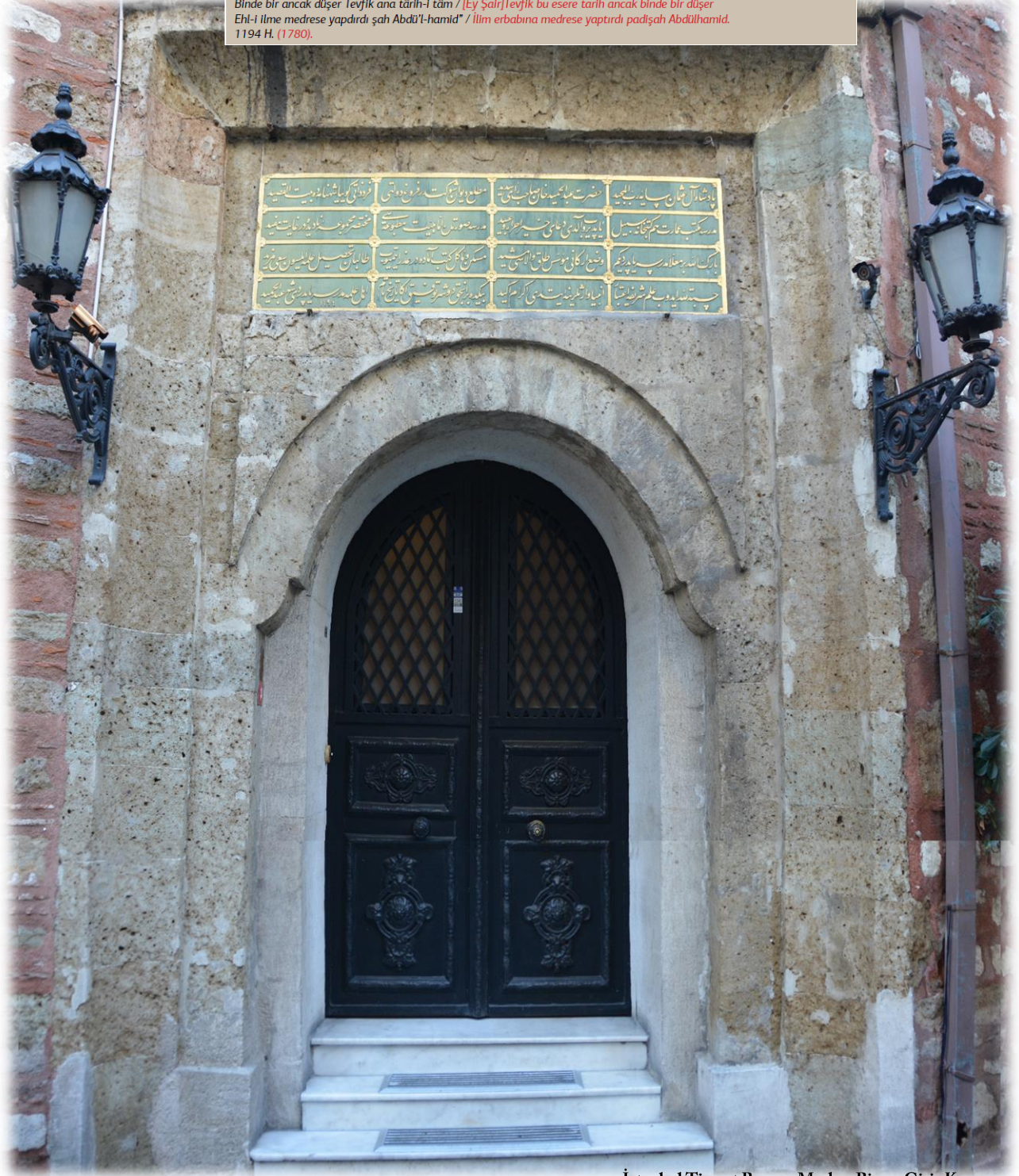
İstanbul Ticaret Borsası Merkez Binası Giriş Kapısı
